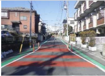
ゾーン30プラスによる路面の カラー塗装などの交通安全対策 （事例：さいたま市浦和区 前地地区ほか）
