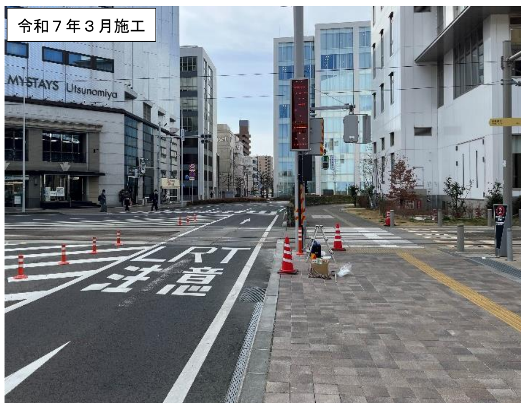
【LED注意喚起標識板の設置】
