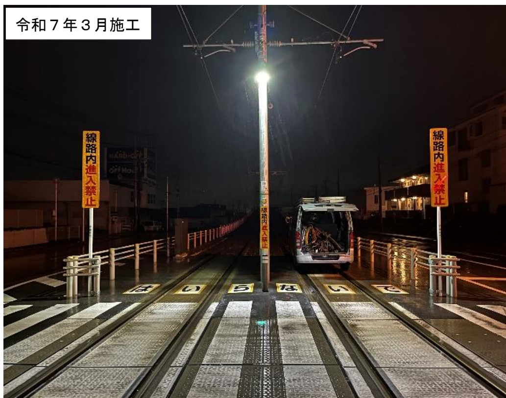
【注意喚起標識板，自発光視線誘導標，軌道照明の設置】
