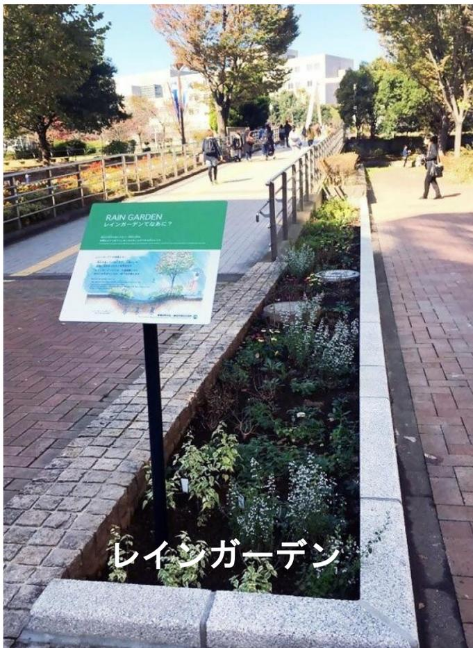
雨水を地中に浸透させることで、地表面に水があふれるのを抑制する効果があります。また、雨水を貯留することで、蒸発散による温熱環境改善など、ヒートアイランド対策にも有効です。
