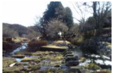
整備された宝木用水取水口
