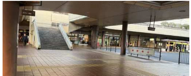
図2.21 駅前広場地上部
