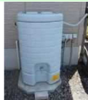
宅地内の雨水貯留タンク
