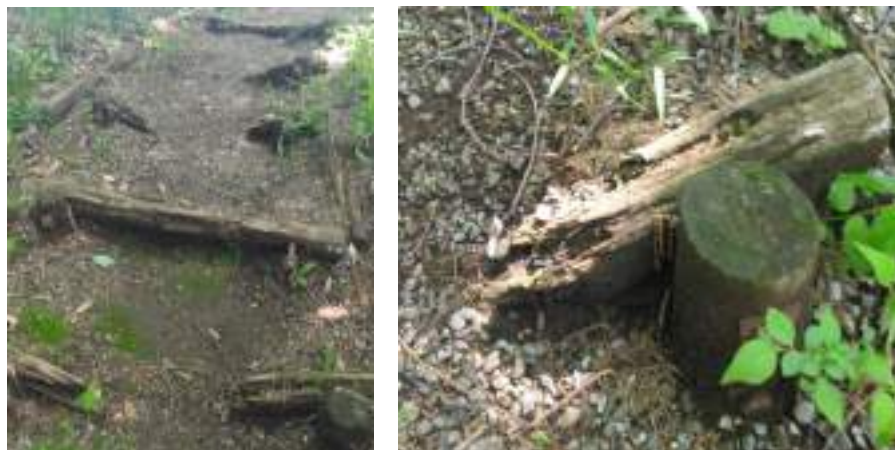
図 58 遊歩道の劣化の様子
