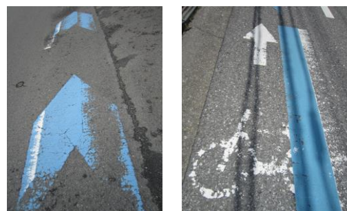
老朽化により視認性が悪化した路面標示
